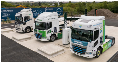
サンダーランド工場の高出力充電設備
